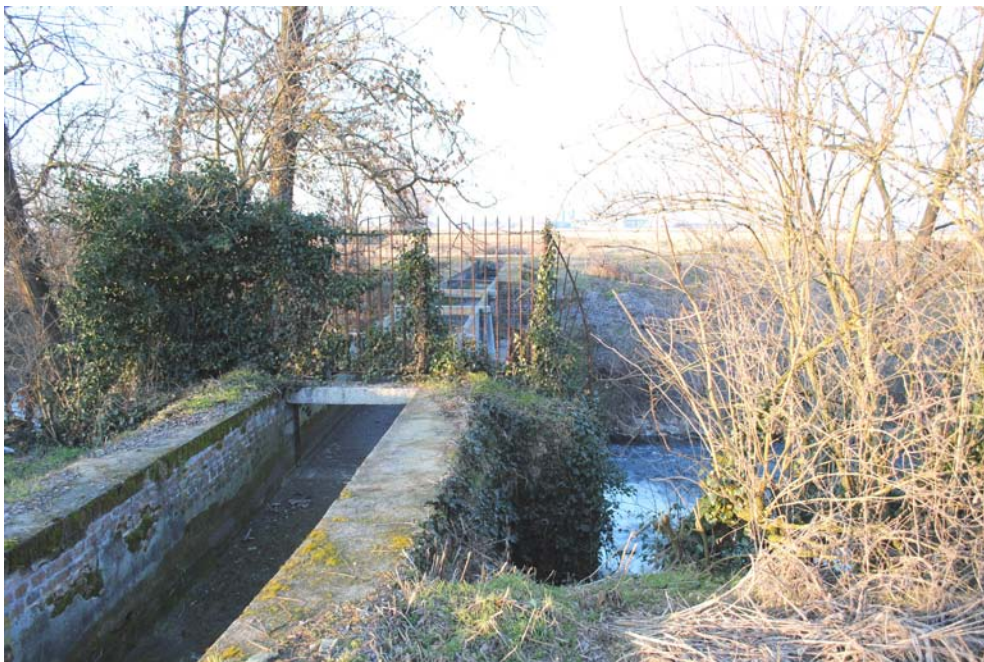
Immagine di una delle pochissime dame sopravvissute su un ponte-canale della Muzza
