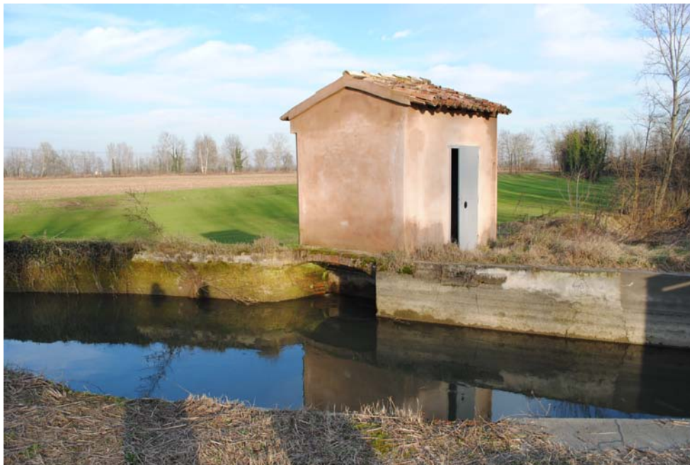
Casello presente sul colatore Muzza presso ponte-canale roggia Cavallera-Crivella
