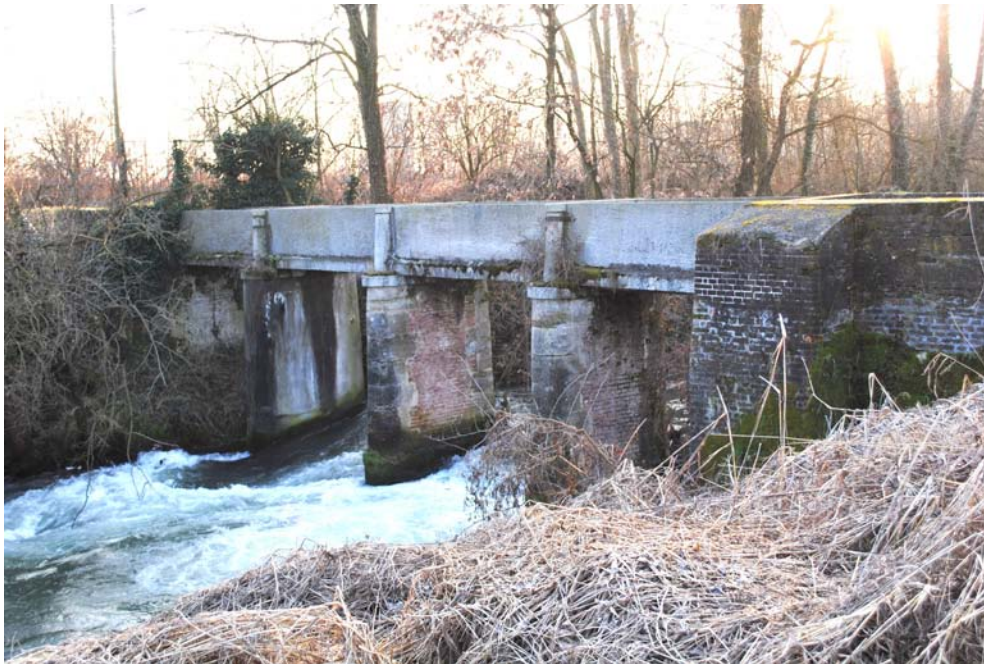
Altro pregevole esempio di ponte-canale in “cotto e vivo”
